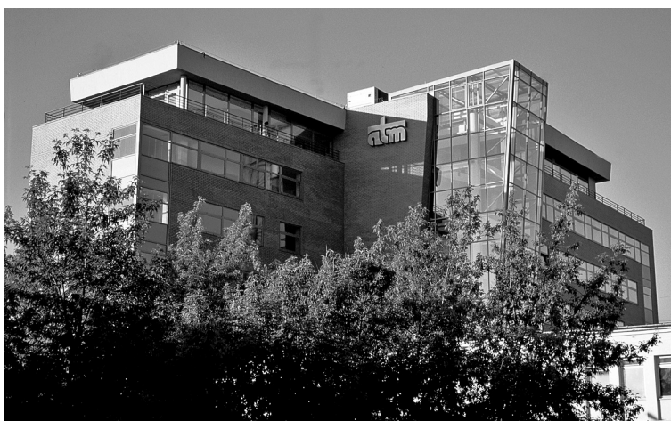
Rysunek 5.10. Nowy budynek Centrum Telekomunikacji ATM i siedziby Emitenta przy ul. Grochowskiej 21a w Warszawie
